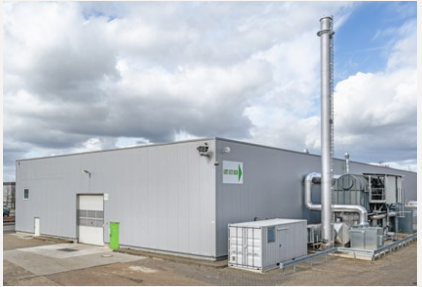
Außenansicht Werk 3 des familiengeführten Imprägnierspezialisten Hans Schmid GmbH & Co. KG in Gronau
